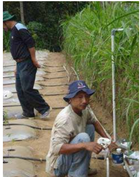
Gambar 6. Pemasangan saluran primer yang menghubungkan tandon air dengan lahan yang akan diairi.
