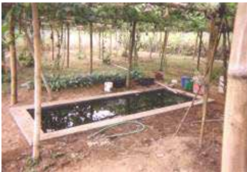
Gambar 1. Bak penampungan permanen ukuran 1m x 3m x 1m untuk mengairi lahan pertanian sekitar 1000 m 2 di Desa Pandean, Kecamatan Ngablak Kabupaten Magelang (introduksi BPTP Jateng 2006)
