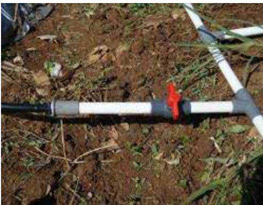
Gambar 7. Pemasangan saluran sekunder yang terhubung dengan saluran primer.
